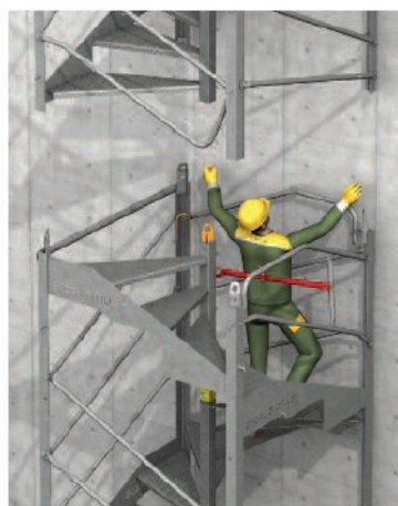
POSE OU DEPOSE D'UN MODULE
